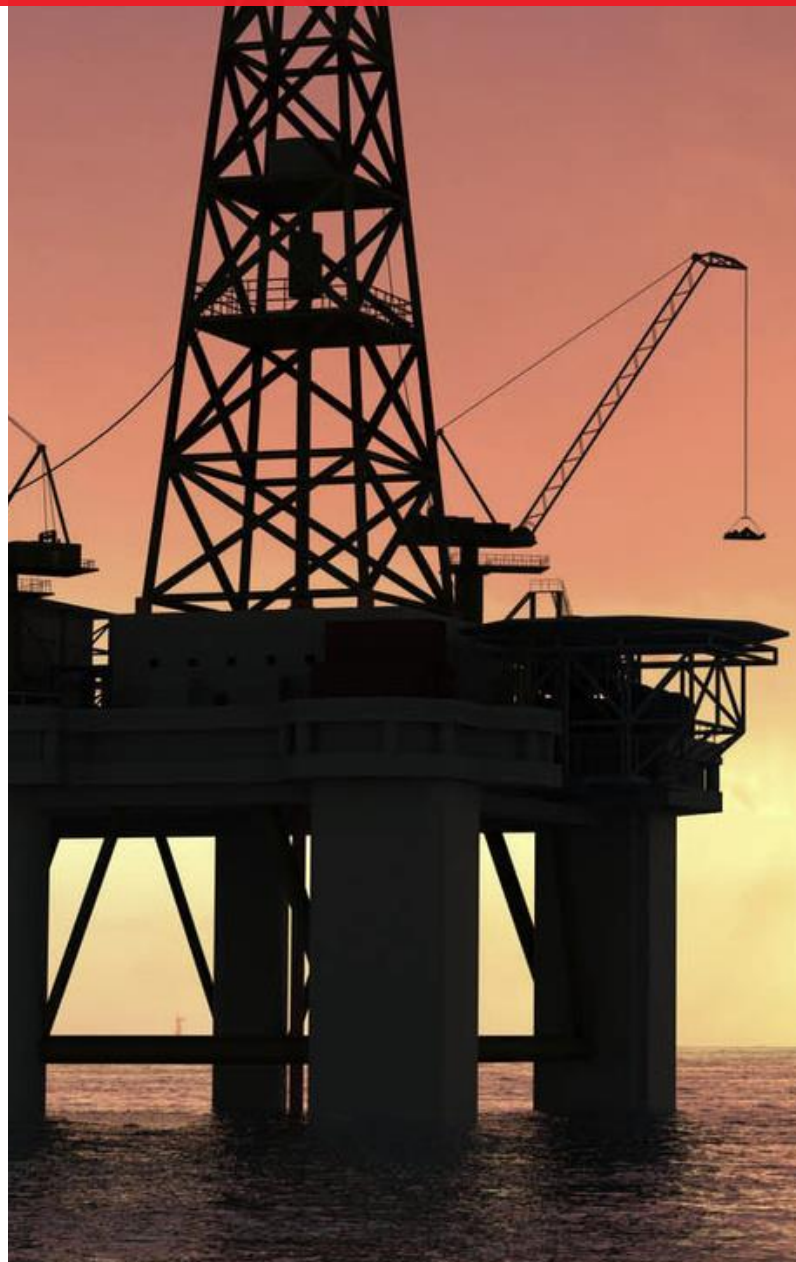
Konštrukcie uložené v morskej vode
